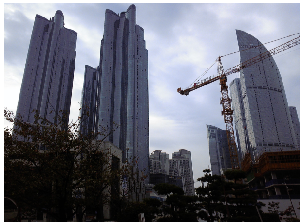
図2 釜山の高層マンション
