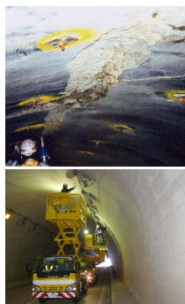
老朽トンネル検査診断
