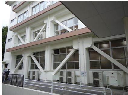
図2 CFT ブレースによるRC構造の耐震補強
